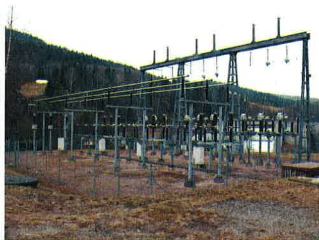
Bilde 8-4: Bildet viser et typisk koblingsanlegg av typen som er tenkt etablert ved Øyan. (Foto: Skagerak Kraft AS)
