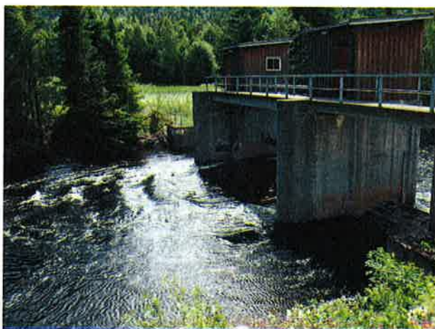
Bilde 7-23: Betongdammen ved utløpet av Hjartsjø (Foto: Skagerak Kraft AS)
