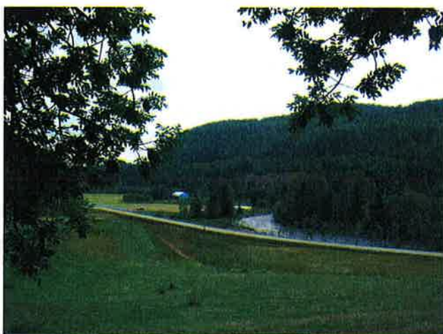
Bilde 8-3: Hjartdøla sett fra Øyan gård. Til høyre langs elva sees området der koblingsanlegget er tenkt plassert. (Foto: Line M Valle, SWECO)
