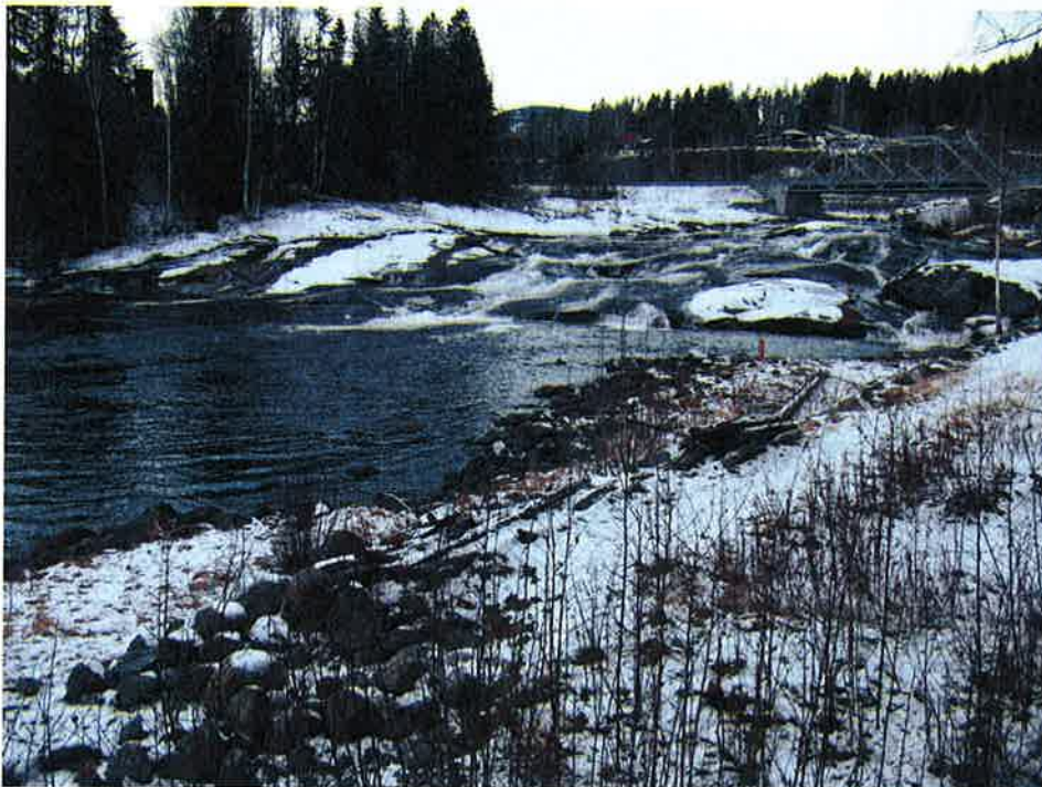
Bilde 7-21: Omnesfossen med vannføring 5,5 m 3 /s, november 2007. Dette kan sammenlignes med middelvannføring etter utbygging (Lancaster, 2008) (Foto: Skagerak Kraft AS)
